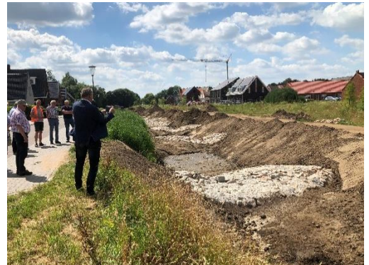
Vistrap in aanleg
